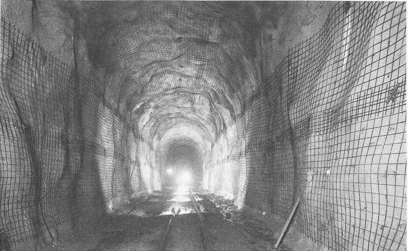
Bild 8. Stahldrahtnetze als Armierung der Spritzbetonauskleidung
