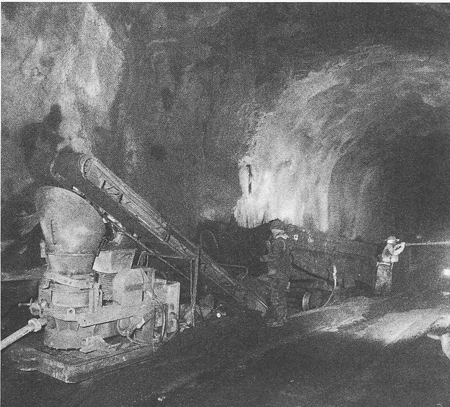
schnellerhärtenden Bindemittel. Im Furka-Tunnel ist das Produkt «Sika-Shot» der Firma Sika AG verwendet worden. Seine Druckfestigkeit beträgt nach einer Stunde  $12 \text{ N/mm}^2$  und nach 28 Tagen etwa  $45 \text{ N/mm}^2$ .
