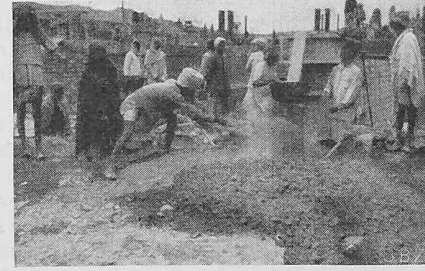
Bild 23. Nangal-Sperre. Mischen des Betons; im Bilde festgehalten die Zementzugabe.
