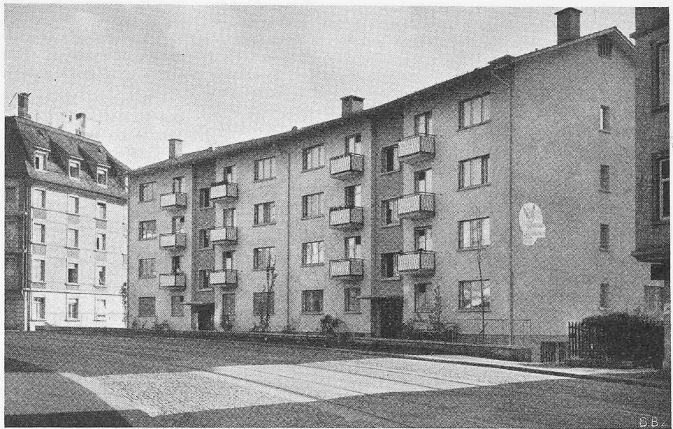
Bild 6. Fassade an der Forchstrasse aus Norden
