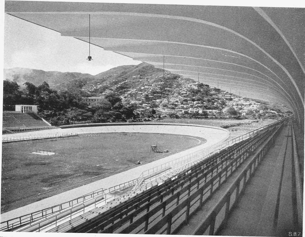
Blick von der Nordtribüne auf die Piste
