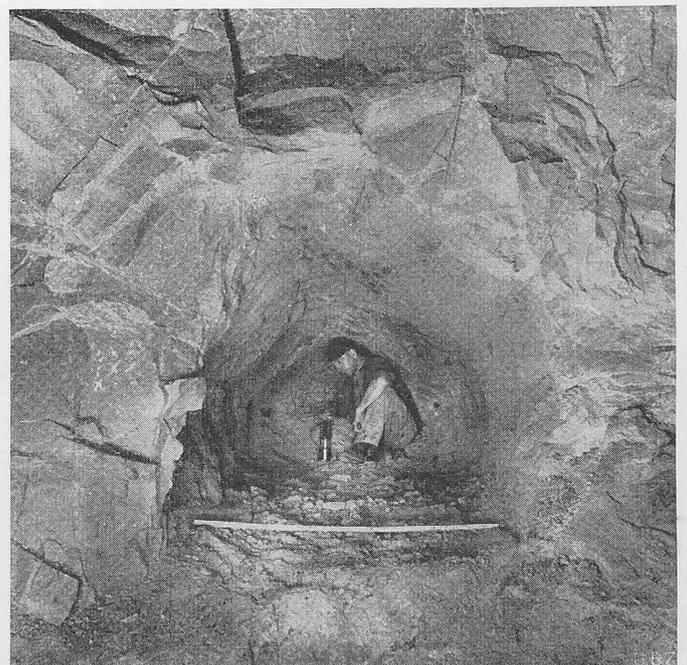
Bild 24. Brenneinbruch nach Bild 23a auf der Zeche Neu-Iserlohn (Photo Deutsche Kohlenbergbauleitung)
