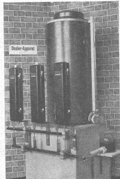
Dosier-Anlage für 3-Pumpenbetrieb mit el. Steuerung
