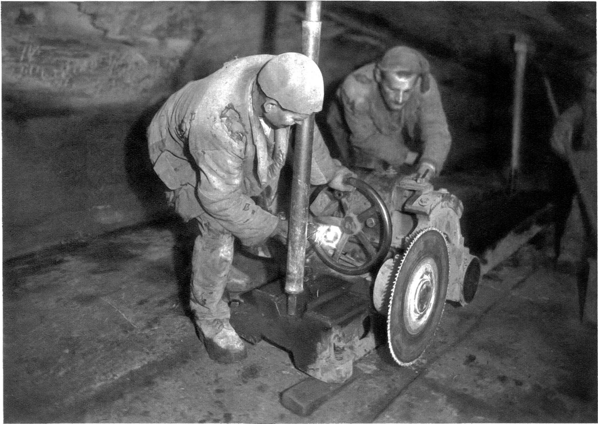
Die Fräsmaschine im Stollen
