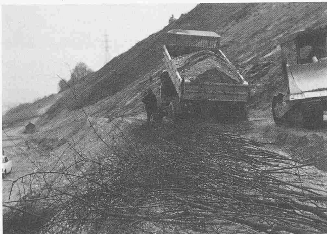
Bild 5. Buschlagenbau während der Schüttung
