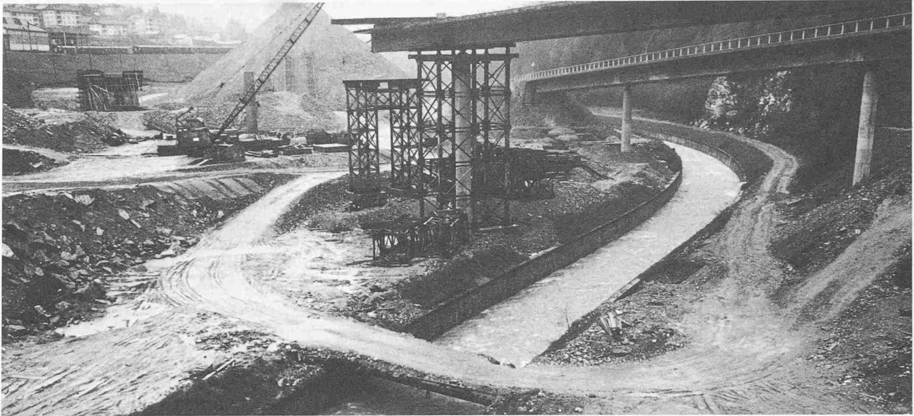
Bild 1. Kanalisierter Flussabschnitt im Raume von Airolo
