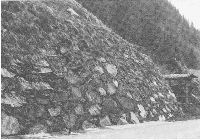
Bild 6 und 7. Bepflanzte und beraste Trocken-Blockschichtung zur Abstützung einer durchnässten Steilböschung. 5 Jahre alt
