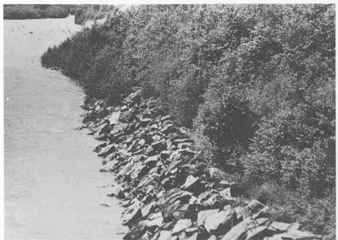
Bild 13 (unten). Blockwurf zur Ufersicherung, hier richtig flach geschüttet. Vorne nicht bepflanzt, hinten bepflanzt. 9 Jahre alt
