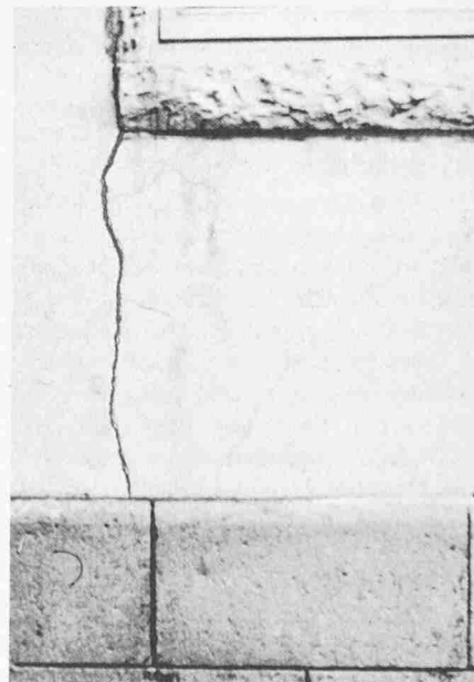
Bild 5. Thermische Risse
