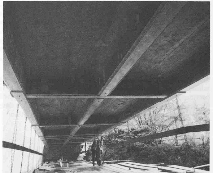
Bild 5. Gesamtansicht der Brückenunterseite mit den geklebten Verstärkungsblechen auf den Längs- und Querträgern
