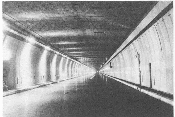
Bild 3. Notbeleuchtung mit eingeschalteter Brandnotbeleuchtung
