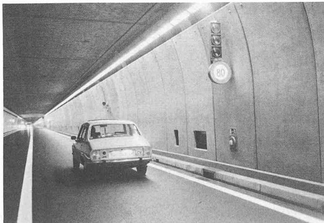
Bild 2. Beleuchtung der Mittelzone
