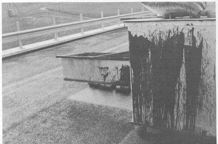
Bild 15. Maschinelles Einstreuen von Gummigranulat als Haftvermittler
