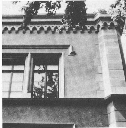
Bild 5b. Soll-Zustand nach Sanierung. Ersatz, Ergänzung, Aufmörtelung. Flächige Konservierung
