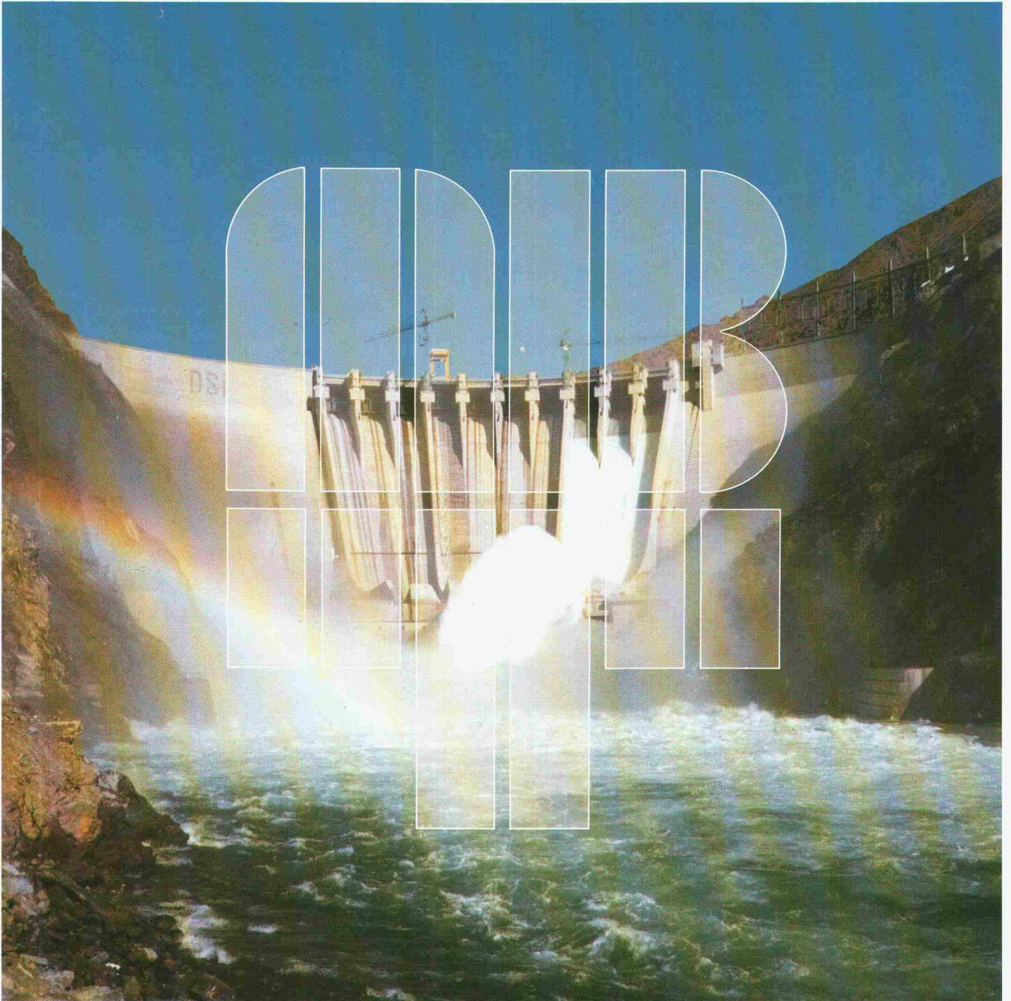
Karakaya-Staudamm in der Türkei: 630000 m<sup>3</sup> Beton mit Rheobuild Superverflüssiger.
