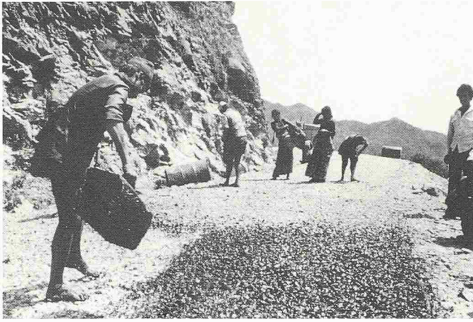
Bild 1. Arbeitsintensiver Strassenbau in Nepal: hier der vom Bund finanzierte Bau einer Strasse von Lamosanghu nach Jiri, Ostnepal, (im Gebiet des nepalesisch-schweizerischen «Integrated Hill Development Project IHDP»). (DEH-Fotothek/Max Lehmann)
