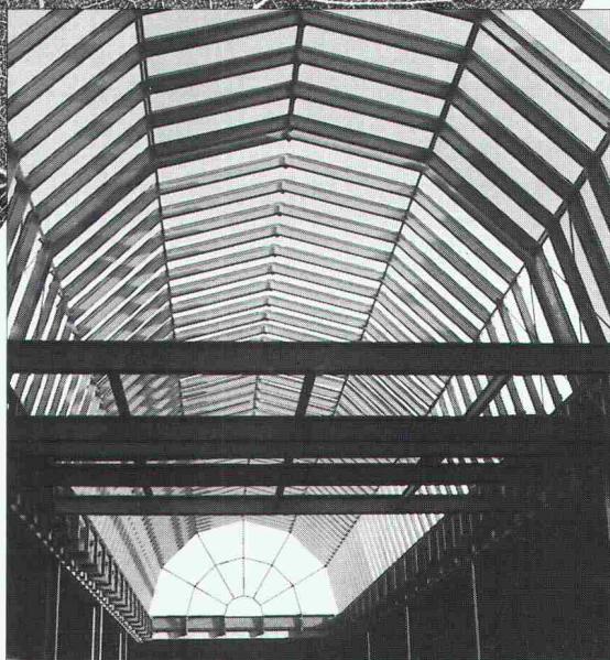
Stahl- und Industriebau
