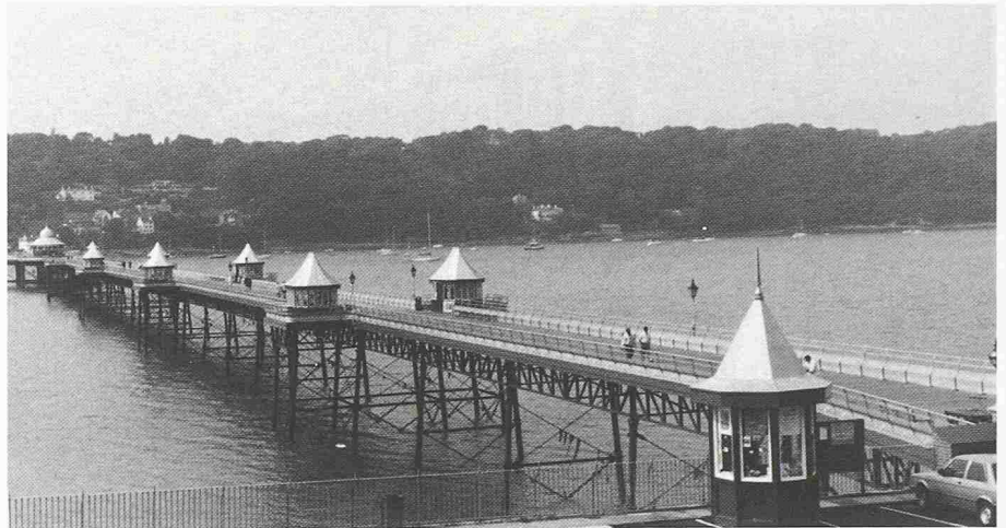
Bangor Pier, vor Zerfall gerettet durch Restaurierung 1983–88. Promenadensteg auf Pfählen, 500 m lang, 8 m breit, Tragwerk aus Gusseisen und Stahl, darüber Holzplanen. Gehört zu besterhaltenen Piers in Grossbritannien. Auf dem «Wasser spazieren» war der Wunsch der viktorianischen Gesellschaft, Pier-Architektur als Zeugnis einer Gesellschaftsform
