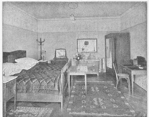
Abb. 8. Fremdenzimmer im zweiten Obergeschoss.
