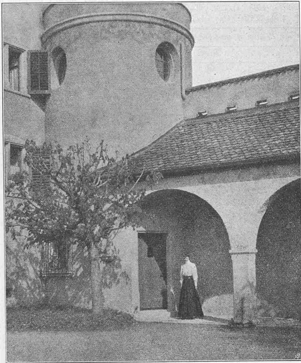
Abb. 7. Neuer Eingangsturm und Vorhalle.
