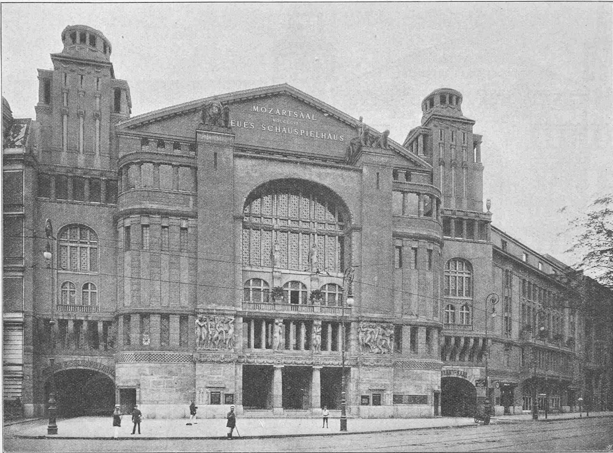
Abb. 5. Fassade mit Haupteingang und Einfahrten am Nollendorfplatz.
