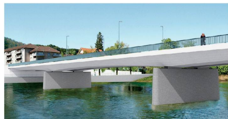
05 «Zweistein»: Der Querschnitt des Dreifeldträgers kann als trapezförmige Platte mit Längsnut oder als zweistufiger Plattenbalken mit breiten Stegen betrachtet werden. Die Trägerhöhe verläuft dem Momentenverlauf entsprechend leicht gekrümmt. Die Pfeiler werden um etwa 1.80 m aufbetoniert
