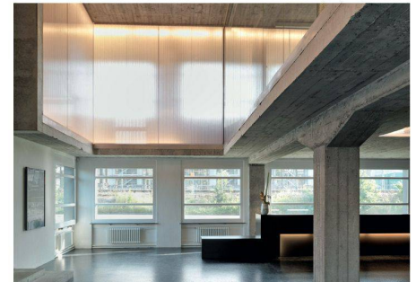
03 Die transluzente Innenfassade fasst das Obergeschoss räumlich zusammen
