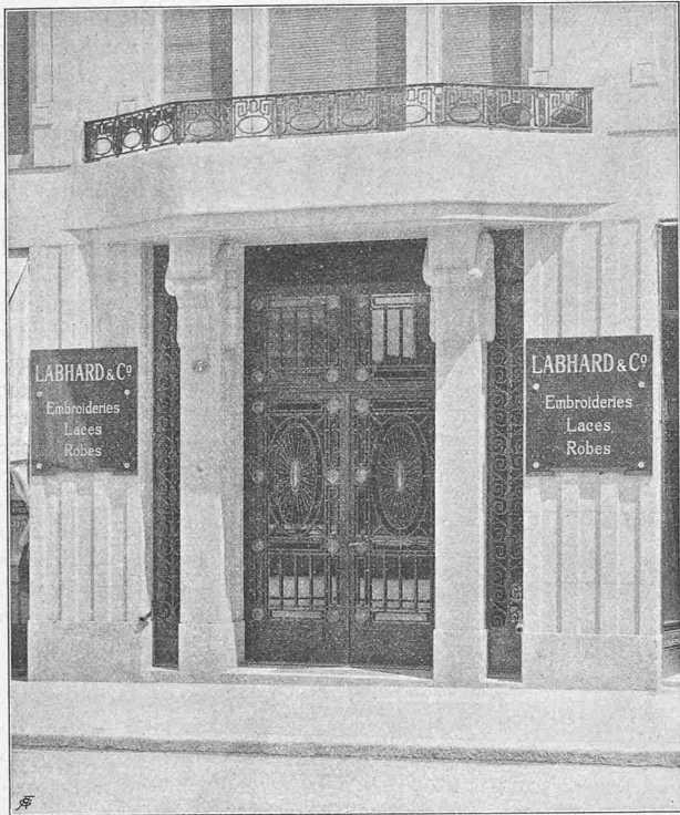
Abb. 7. Haupteingang an der Kornhausstrasse.
