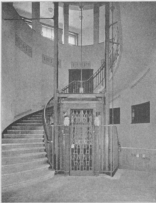
Abb. 8. Die Banktreppe im Erdgeschoss.
