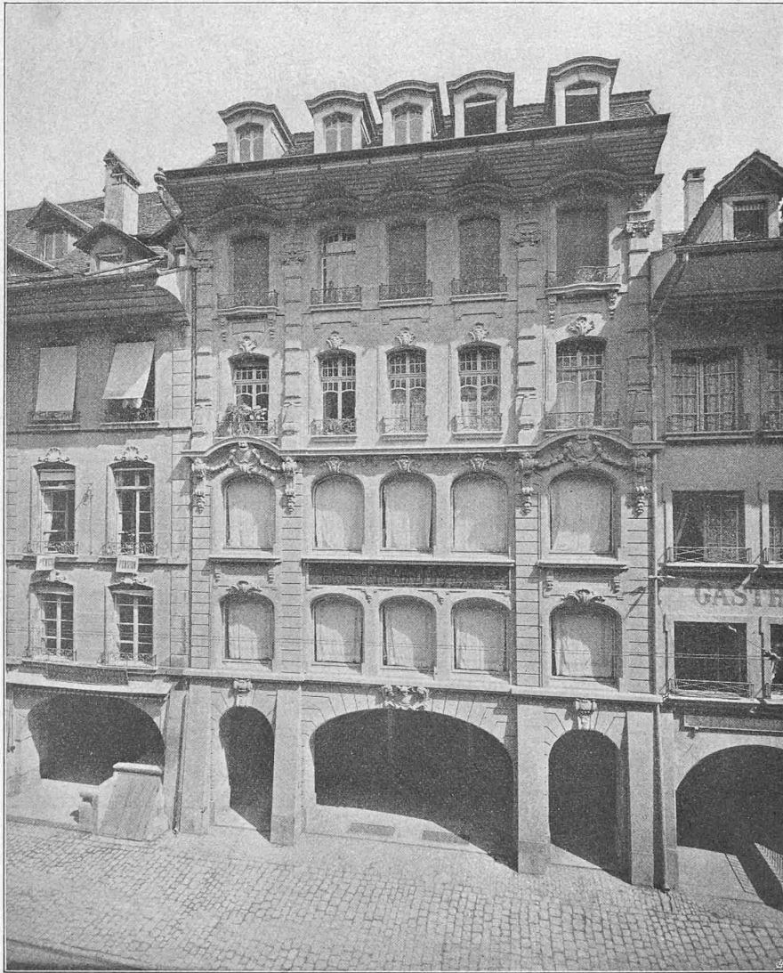
Abb. 10. Fassade und Laubengang an der Marktgasse.
