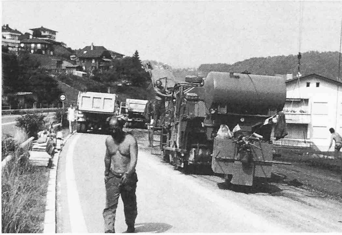
Bild 5. August 1980: Fräsarbeiten auf den seeseitigen Fahrspuren. Verkehrsführung: Gegenverkehr auf der Bergseite
