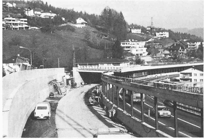
Bild 8. Nov. 1981: Versetzen der Betonrippenplatten auf Rückwand und Längsträger über der Mittelmauer. Verkehrsführung: Gegenverkehr auf der Seeseite
