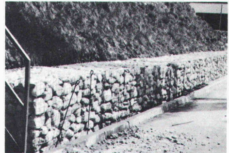
Beispiel einer Böschungserbauung
