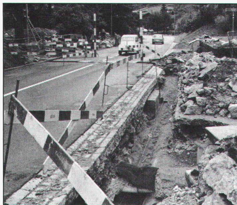
09.57 Das Zugseil ist in den Graben eingelegt...
