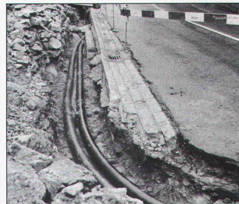
11.55 Komplett verlegt – 360 m nahtlose Fernwärmeleitung – Ziel erreicht!
