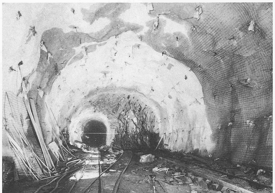
Bild 14. Erweiterungsbauwerk während des Baus
