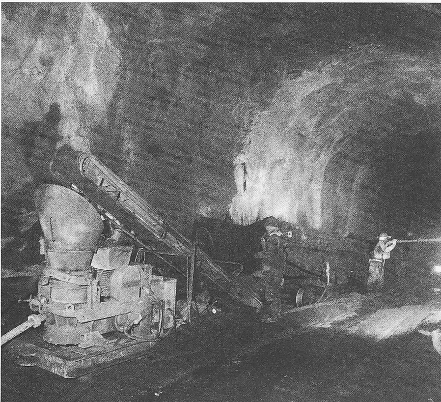
Bild 9. Spritzbetonmaschine, Beschickungsförderband und Bunkerzug mit Trockengemisch
