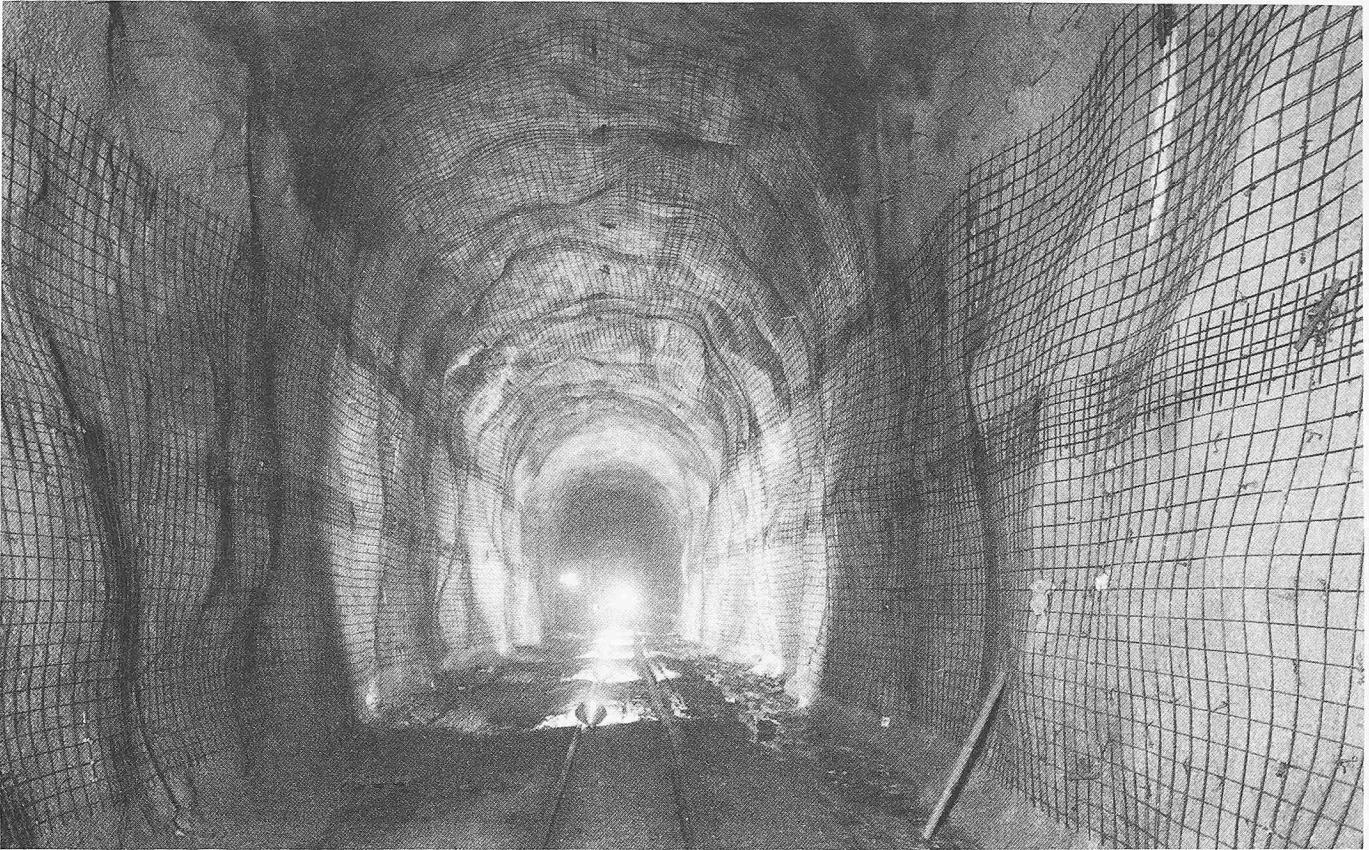
Bild 8. Stahldrahtnetze als Armierung der Spritzbetonauskleidung
