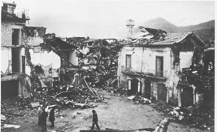
Bild 14. Alter Dorfteil von S. Michele di Serino als typisches Schadenbild für Natursteinbauten bei einer Intensität VIII. Berge von Schuttmassen liegen in den Strassen und verunmöglichen einen raschen Rettungseinsatz
