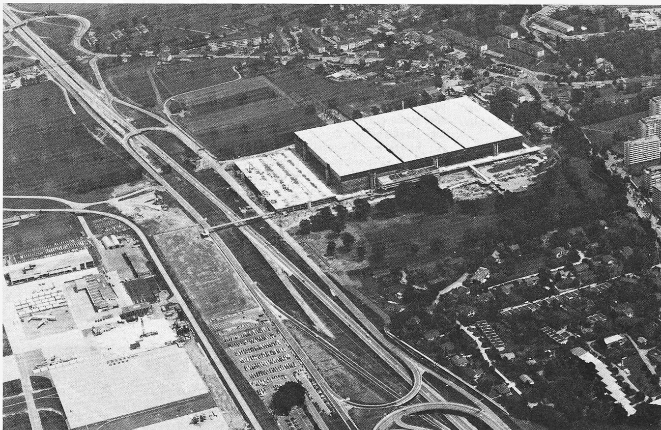
Luftaufnahme des Palais des Expositions et des Congrès. Links: Flughafen Cointrin mit Parkplatz, unter welchem der künftige Flughafenbahnhof geplant ist. Rechts im Bild: Die Umgebung von Grand-Saconnex
