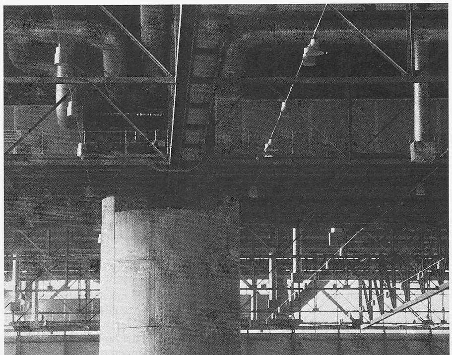
Fertige Stahlkonstruktion im Bereich eines Auflagerturms
