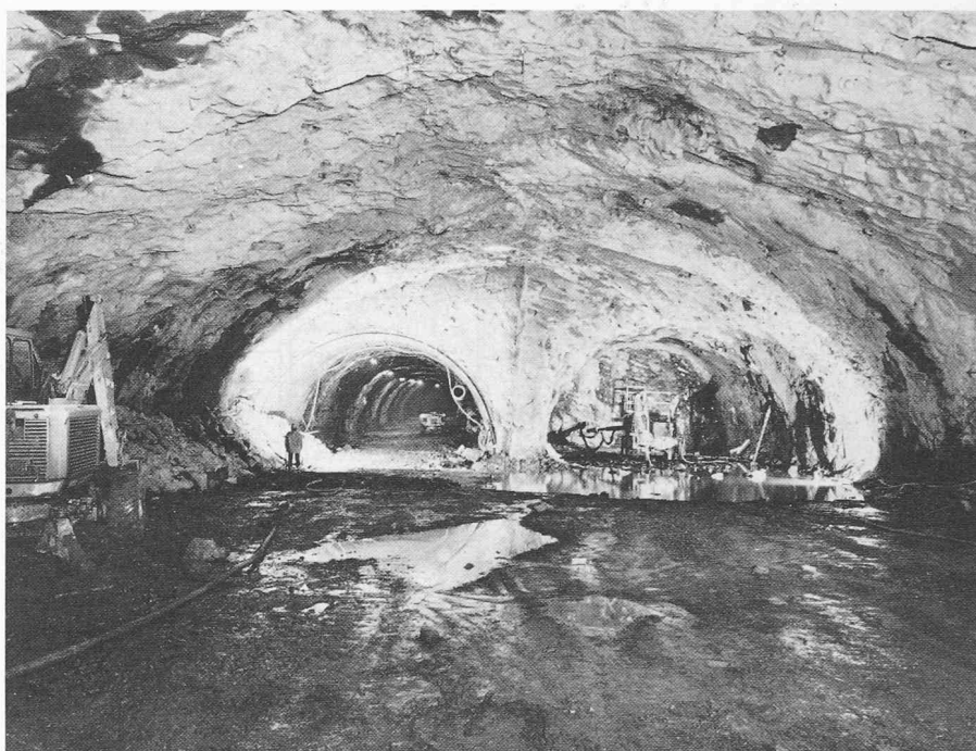
Bild 2. Kalottenausbruch in der Verzweigung. Links Haupttunnel Richtung Luzern mit Stahlbau zur Sicherung des Mittelpfeilers, rechts Beginn des Ausbruchs im Anslusstunnel
