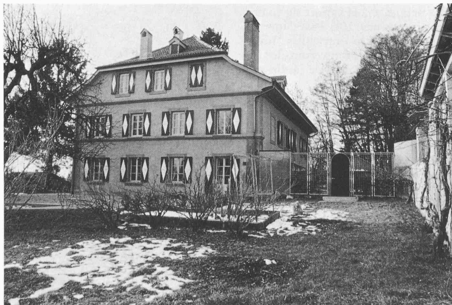
La démolition de l'ancienne annexe permet de rééquilibrer la façade et de mettre en relation la cour et le jardin
