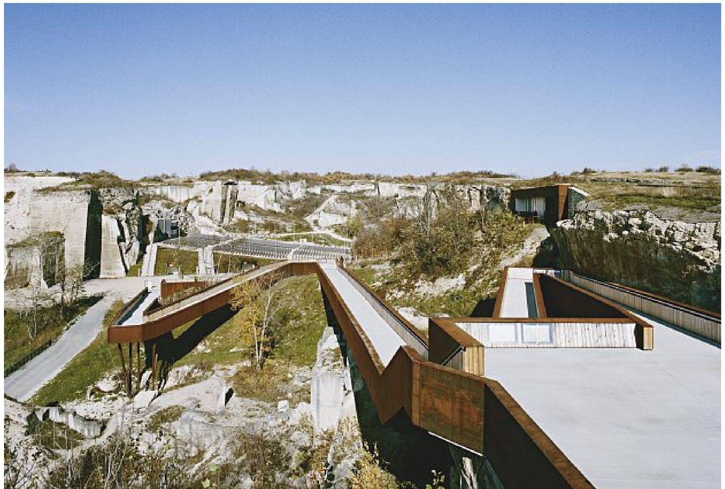
Insenierter Abstieg in den Steinbruch: Die Zugangsrampe führt in zwei Spitzkehren hinunter zum Foyerpark.
