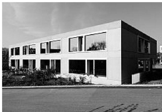
Blick von Nordosten auf den zweigeschossigen Baukörper
