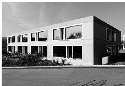
Blick von Nordosten auf den zweigeschossigen Baukörper
