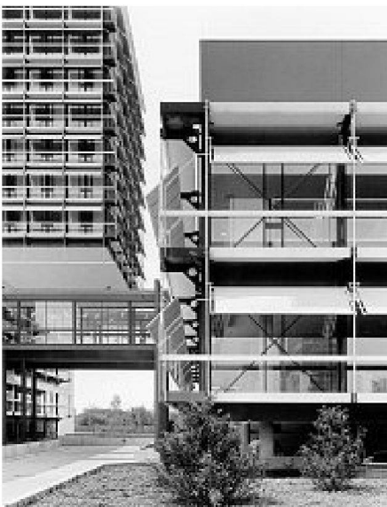
Egon Eiermann, Verwaltungs- und Ausbildungszentrum der Deutschen Olivetti, Frankfurt a. M., 1968-1972; Aufnahme 1974
