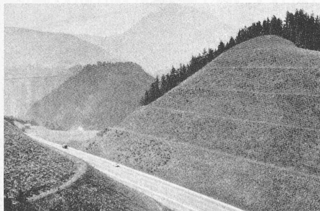
Bild 8. Durch Schichten ® beraste, über 100 m hohe Einschnittböschungen in sterilem Terrassenschotter, 4 Jahre alt. Brenner Autobahn
