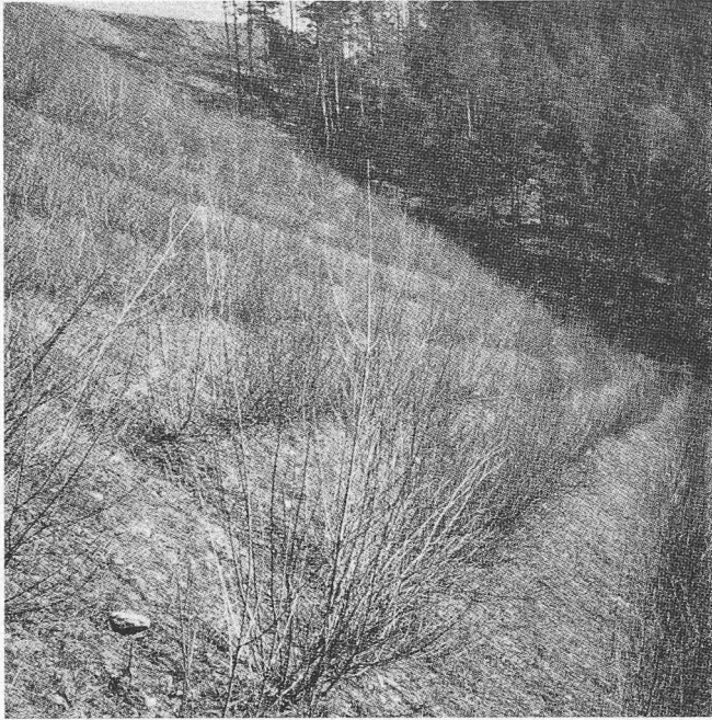
Bild 7. Dreijährige Heckenbuschlagen in einer Dammschüttung, mehrere Meter lang verlegt
