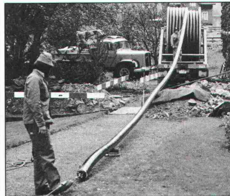
10.04 Die Verlegung der FLEXWELL-Leitung beginnt...
