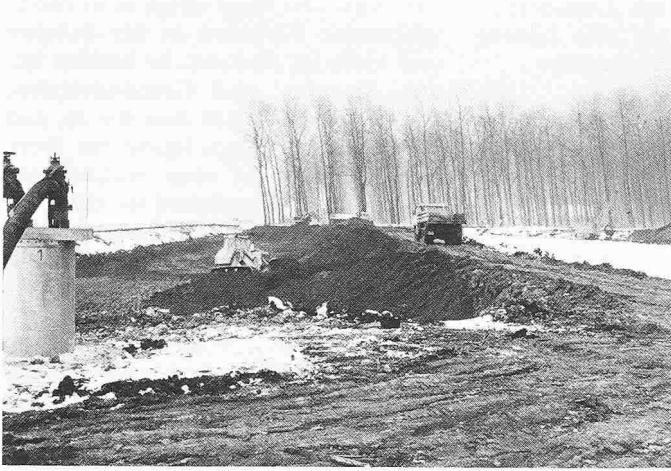
Bild 2. Fundationsarbeiten in der zukünftigen gesicherten Deponie in Collombey-Muraz. Vor dem Einbau der verschiedenen Dichtungsschichten musste der Boden durch eine Grundwasserabsenkung stabilisiert werden
