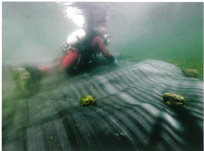
Abb. 4: Sutz-Lattrigen, Rütte. Über der Erosionskante werden als Schutzmassnahme Geotextile ausgebracht, die dann mit einer Kiesschüttung beschwert werden.
