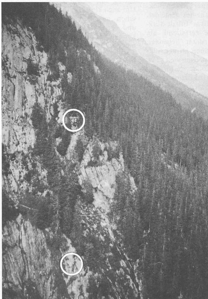
Bild 2. Der Felsturm ob Schwandi am 12. August 1982 von SW vor dem Absturz (Kreise = Referenzpunkte zu Bild 3)
