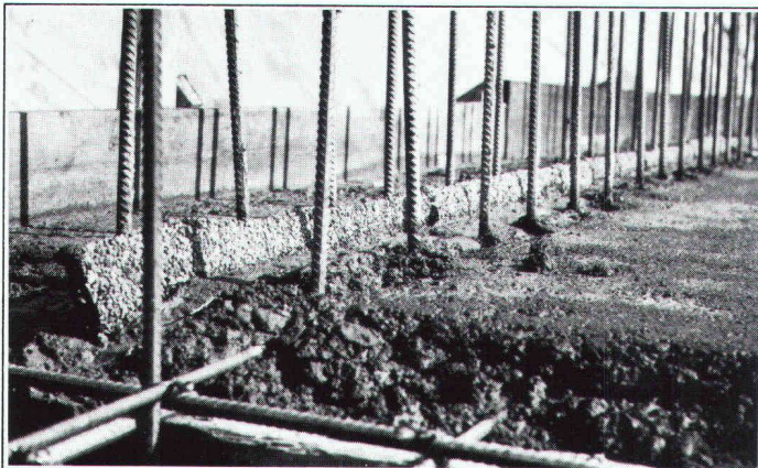
Erstellen einer Anschluss-Dichtung "BFL-MASTIX" Typ 20/70 R4.
