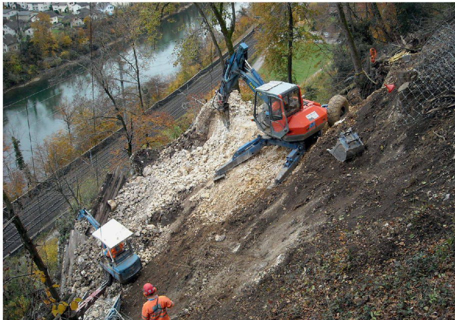
02 Der mechanische Felsabtrag erfolgte mittels Schreitbagger und Hydraulikhammer. Die obersten 12 m des Felspfeilers, die von Hand mittels Presslufthammer abgetragen wurden, sind hier bereits entfernt. Eine Seilbahn erschloss die Baustelle an exponierter Lage (Fotos, Plan und Diagramm: Geotest AG)
