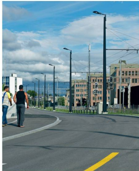
Streckenabschnitt kurz vor der Haltestelle Belair in Wallisellen ZH (Foto: Theodor Stalder)
