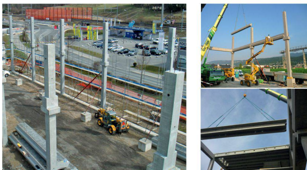
Bild 1: Die fertig montierten Stützen, Bild 2: Montage der Träger, Bild 3: Montage der Rippenplatten
