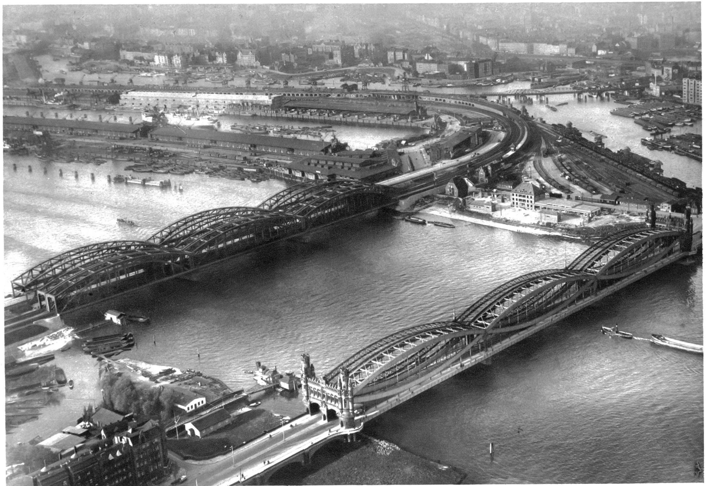
Hamburg, Blick auf die Elbebrücke
