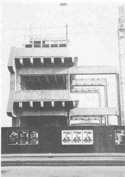
Links: Errichten der vorfabrizierten Betonkonstruktion über die vier Geschosse, von Westen beginnend. - Rechts: Ansicht des westlichen Gebäudetraktes, Vorfabrikation, Anschluss an den in Ortsbeton ausgeführten Kern
