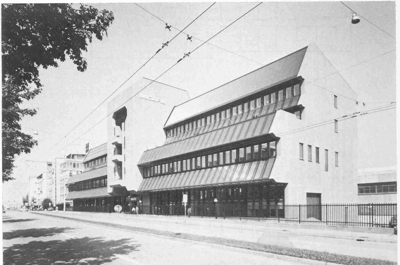
Gesamtanlage von Südosten. Auf dem westlichen Trakt im Dachgeschoss befinden sich Sonnenkollektoren, auf dem östlichen Teil besteht die Möglichkeit, für den späteren Einbau weiterentwickelter Kollektoren. In den Brüstungen des 1. und 2. Obergeschosses erkennt man die Lufikkollektoren
