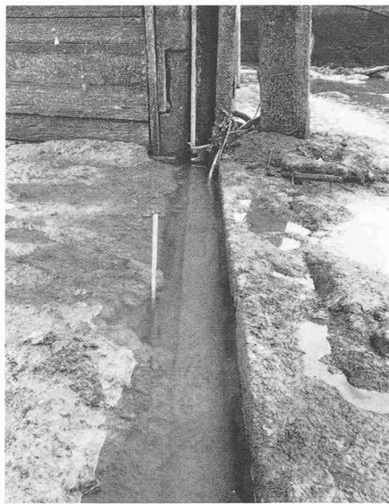
Flickarbeiten in der Wehrsohle mit Unterwasserbeton aus dem 20. Jahrhundert
