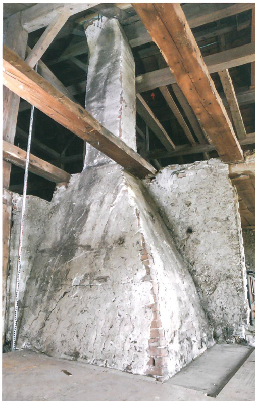
Fig. 5: Plateau de Diesse, Lamboing, Les Moulins 1. Au-dessus du foyer de la cuisine, un magnifique tué en briques revêtu d'un enduit à la chaux est encore conservé. Vue en direction du nord-est.
