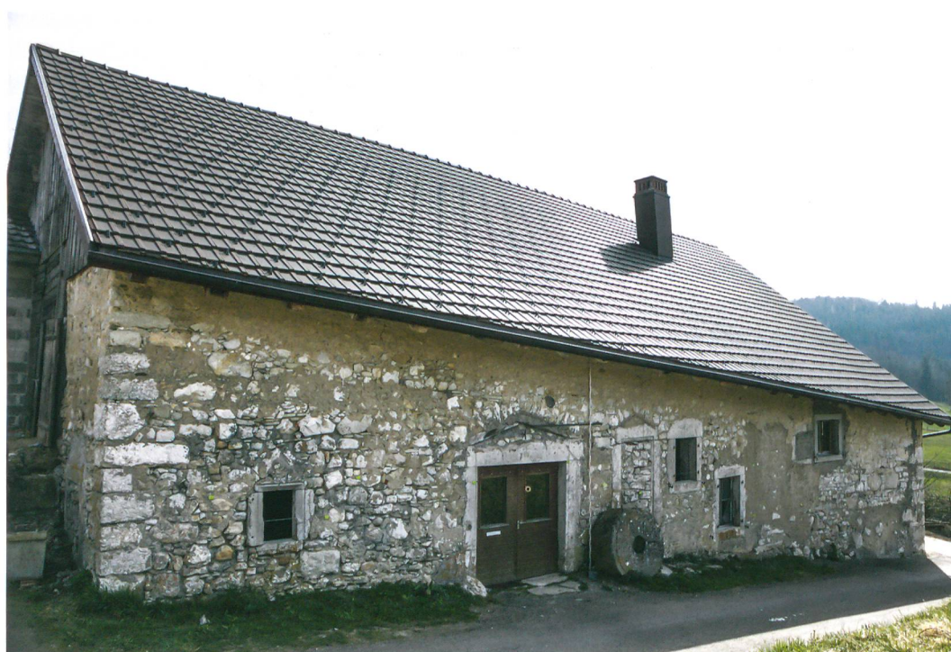
Fig. 6: Plateau de Diesse, Lamboing, Les Moulins 1. Façade ouest avant travaux. Diverses baies, parfois obturées, témoignent des modifications apportées au bâtiment au cours des générations.
